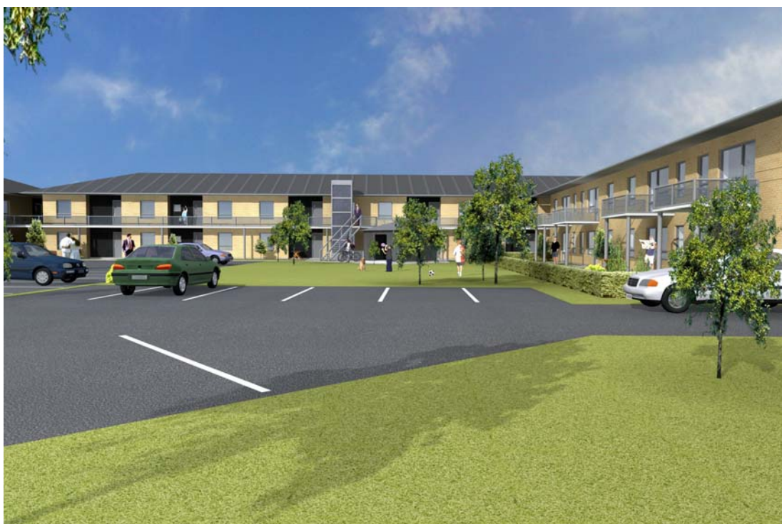
Bygning 1 og 3 set fra gården
